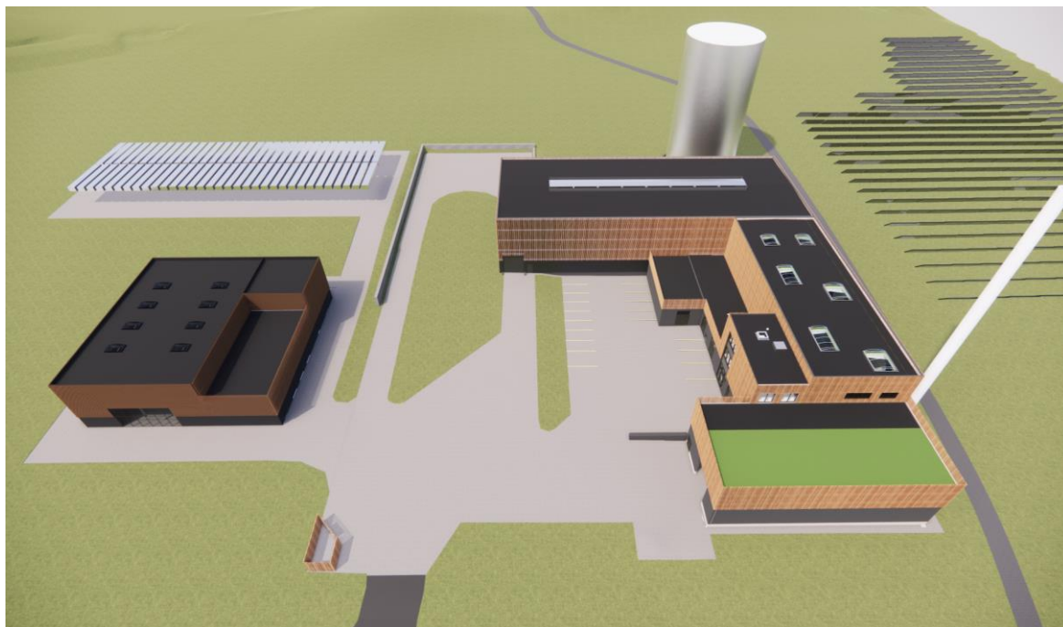
Halsskov Varmeværk: Den firkantede bygning til venstre på billedet illustrerer bygningen, hvori den nye varmepumpe skal bygges. Bag bygningen til højre (nuværende fjernvarmebygninger) ses varmeakkumuleringsstanken.
